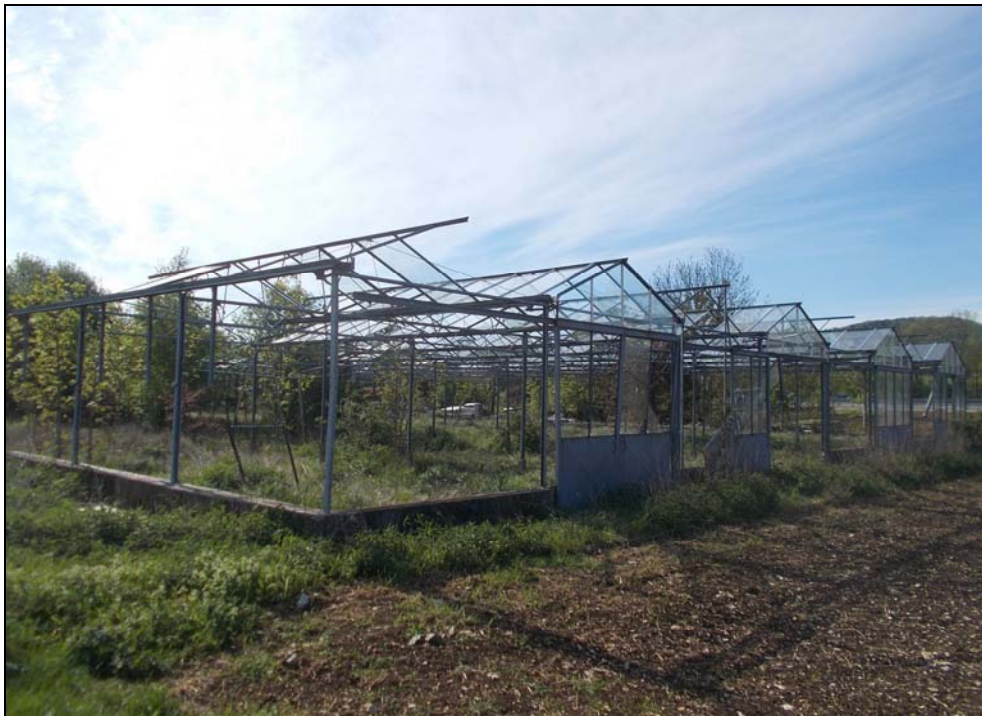
Abb.3: Ehemaliges Gewächshaus (Aufnahme Mai 2020)
